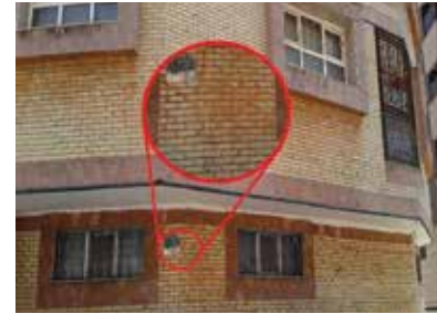
شکل ۱: نمونه از پوشش‌های غیر نفوذی که باعث تغییر رنگ و پوسته پوسته شدن نمای آجری شده است
